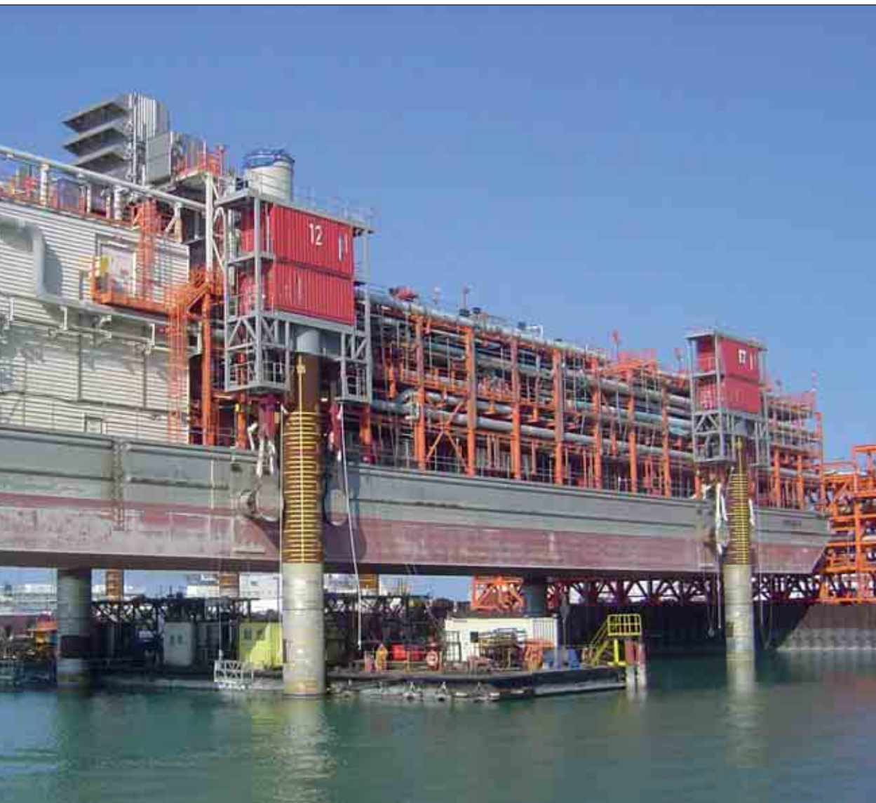
WERK VAN MAMMOET; HET PLAATSEN VAN PRODUCTIEMODULES OP HET EERSTE EILAND VAN HET KASHAGANPROJECT.
